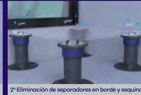
2° Eliminación de separadores en borde y esquina
