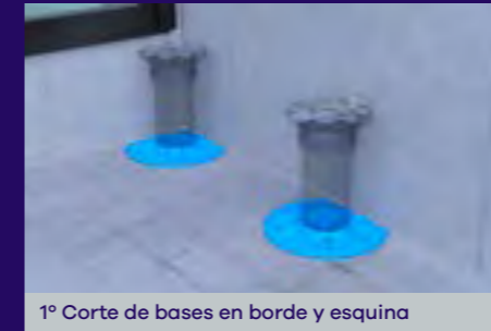
1° Corte de bases en borde y esquina
