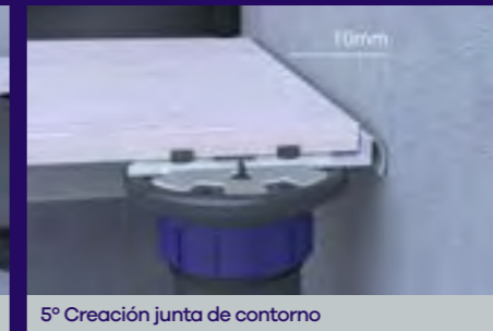
5° Creación junta de contorno
