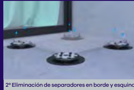
2° Eliminación de separadores en borde y esquina
