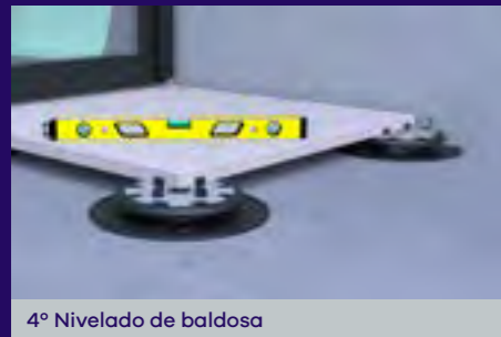
4° Nivelado de baldosa
