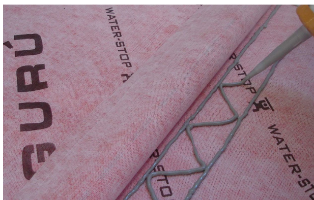
Figura 1.- Realización de la unión del solape con masilla W-S MASTIC
