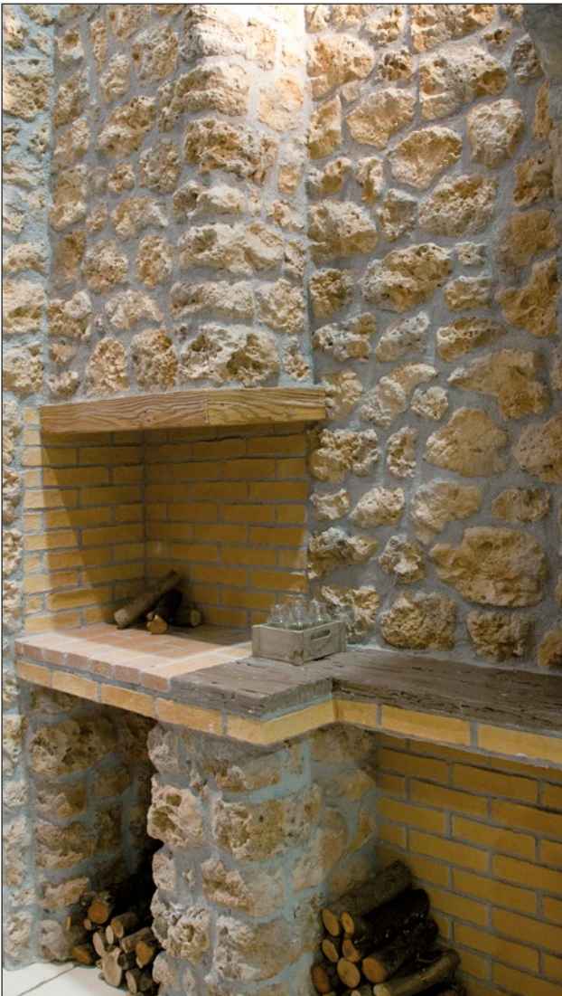
Esquina Timanfaya rejuntado con Morver gris
