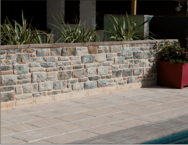
Piamonte aspe rejuntado con Morver pardo
